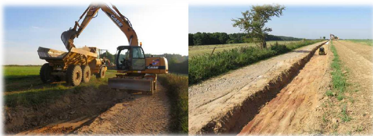
Chantier en cours
